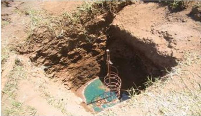
Fabricación de pozos a tierra, mantenimiento preventivo y correctivo.
