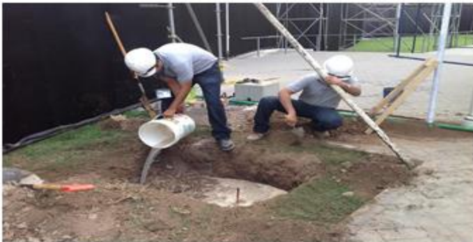
Fabricación de pozos a tierra, mantenimiento preventivo y correctivo.
